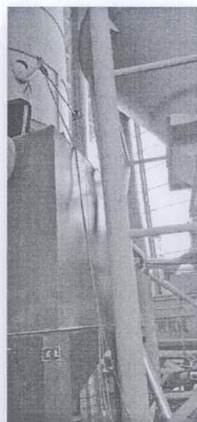
水稳线水泥筒仓工序脉冲布袋除尘器+15m 排气筒
